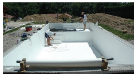
Pose du PVC armé ou liner
