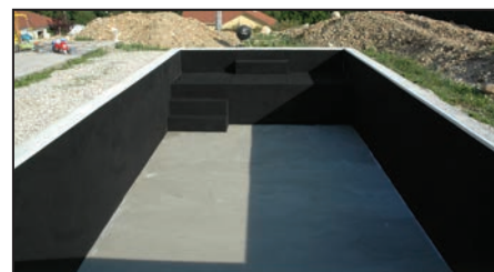
Pose du feutre murs et fond
