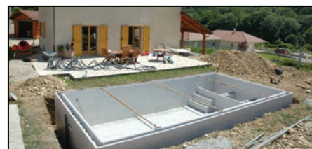
Montage de la structure polystyrène
