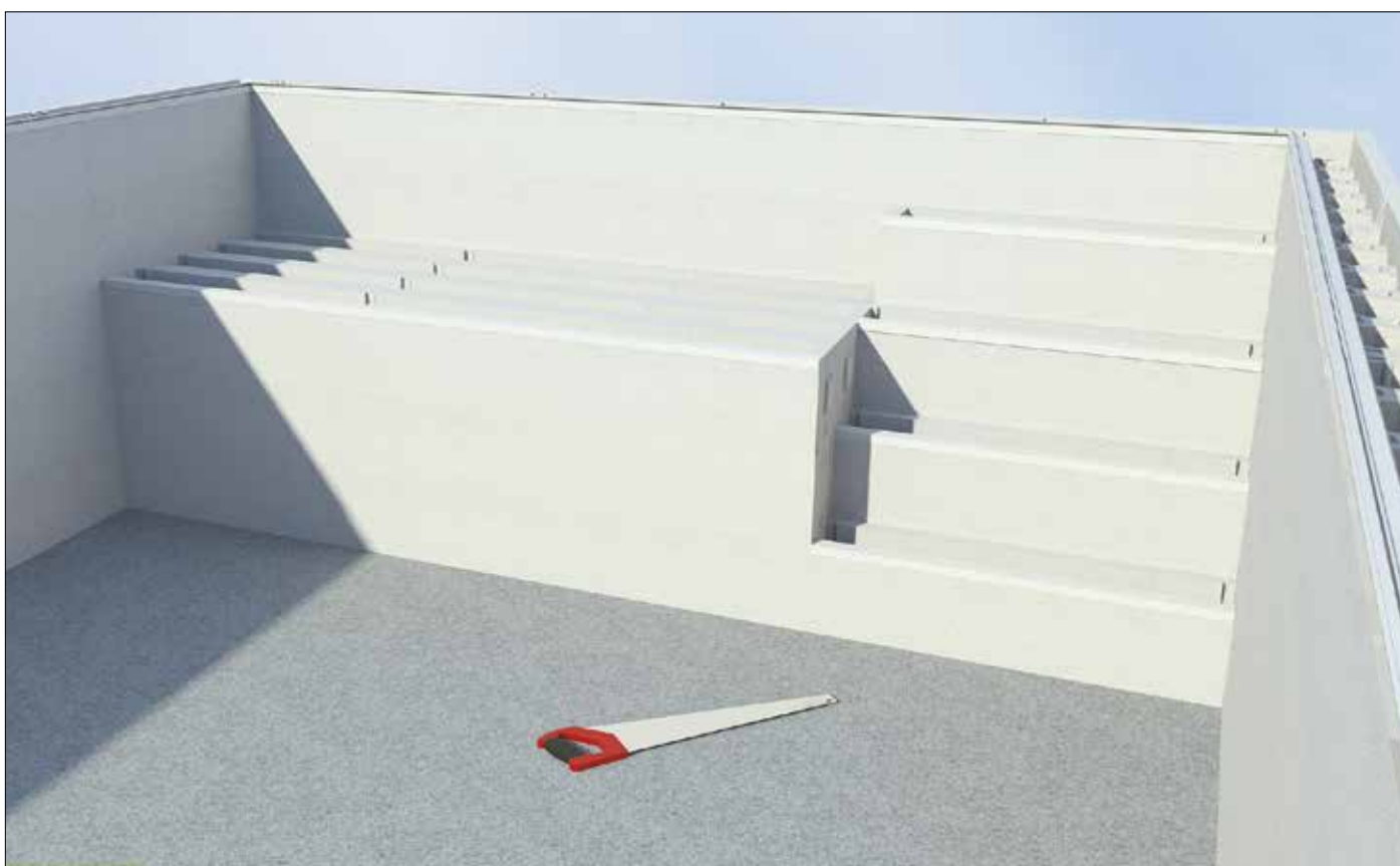
29 Escalier plage fini, la piscine est prête à être coulée
