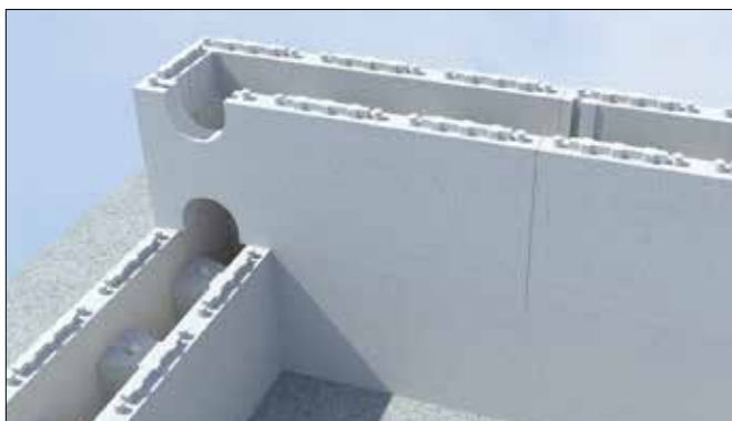
19 Assemblage des blocs d'angles du rang 2
