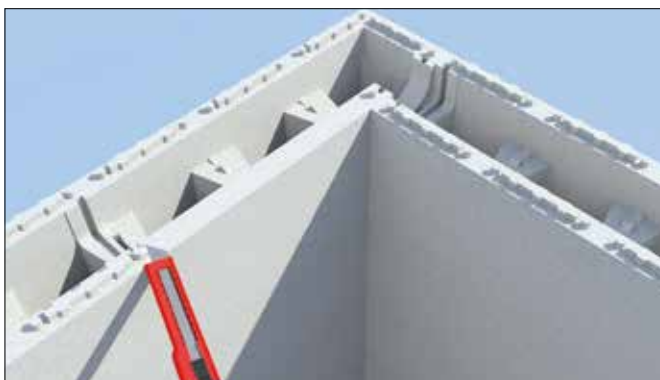
25 Découpe des tenons du dernier rang
