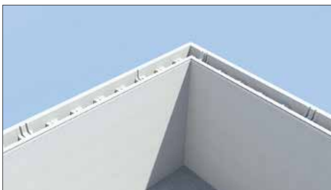
27 Pose du rail d'accrochage du liner suite
